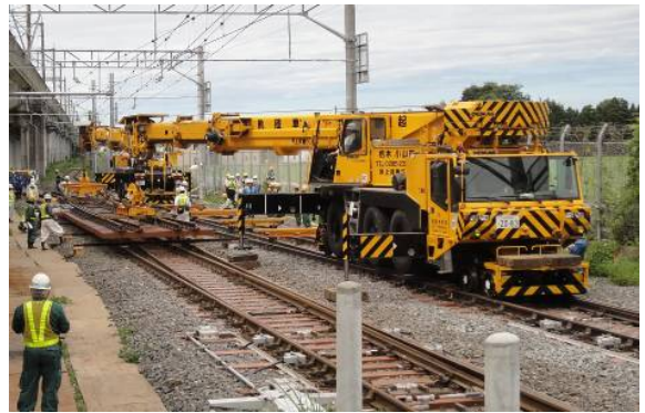
図-7 軌陸クレーン2台(50t)による相吊り
