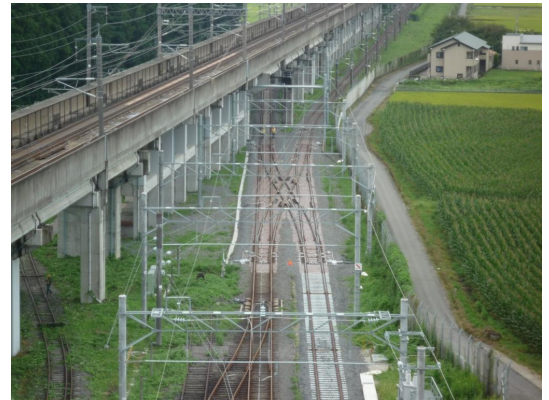
図-1 本工事で敷設したSC
