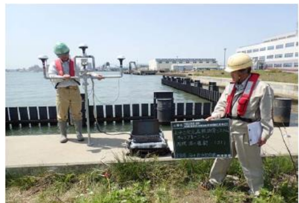
写真-2 精度確認実施状況
